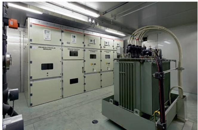
**Bild 12:** Transformatorstation 3 AC 16 kV/400V 50 Hz in Betriebszentrale (Bild 4).
