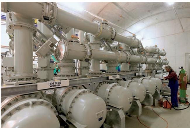
**Bild 7:** SF<sub>6</sub>-Schaltanlage 2AC 132 kV 16,7 Hz Unterwerk Mitholz.
