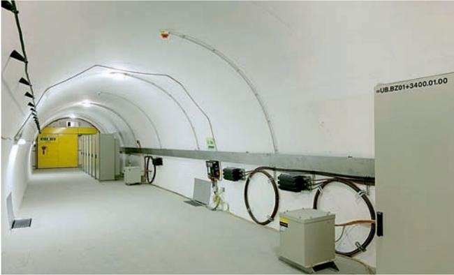
Bild 14: Elektrische Ausrüstung Querschlag.
