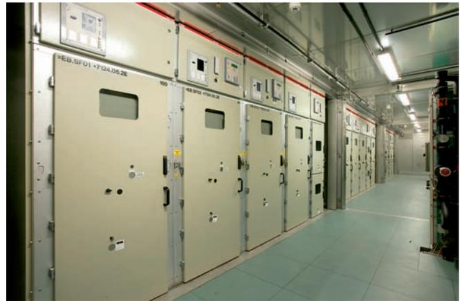
Bild 9: Schaltanlage 1AC 15kV 16,7 Hz in Betriebszentrale (Bild 4).
