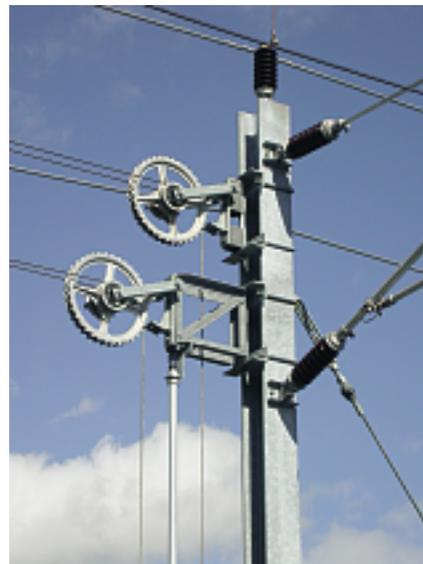
Belastungsgewichte im Falle eines Seilrisses verlässlich verhindert. Die Sektionstrennungen und Streckentrennungen wurden in dreifeldiger Bauweise realisiert.
