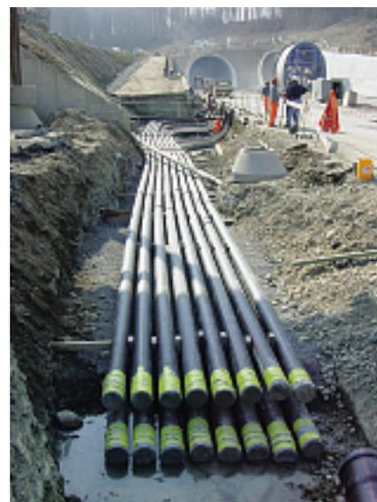
**Bild 12:** Kabelrohrblock Wanzwil für die spätere Aufnahme der 30/18-kV-Einspeisekabel ab Unterwerk Wanzwil. Im Hintergrund rechts späteres Kabelaufstiegsgerüst (Aufnahmerichtung entgegen Bild 2).
