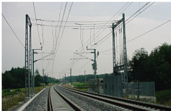
**Bild 3:** Parallelschaltposten (PSP) Rechterswil: Schaltposten rechts mit fünf Lastschaltern und Messeinrichtungen, dahinter Relaisgebäude mit zusätzlicher Einspeisung 16,7 Hz ab Masttransformator (Ansicht Richtung Rothrist).
