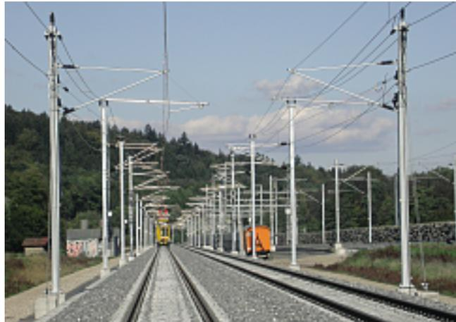
**Bild 4:** Ansicht Oberleitung ELINCAT E230 auf freier Strecke mit direkter Spurhaltung (rechtes Gleis) und Rückgriff-Spurhaltung (linkes Gleis), Verstärkungsleitung auf den Mastspitzen, Stahlmaste und Fundamente nach SBB-Vorgaben, Abfangmaste mit Seilankern.
