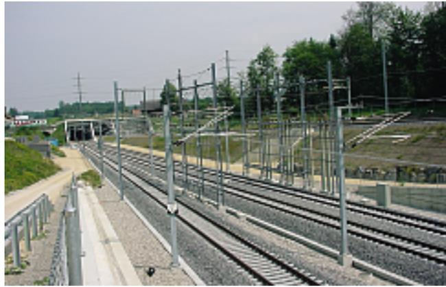
**Bild 2:** Verzweigung Wanzwil Richtung Rothrist: Gleise von links nach rechts: Gleis von Solothurn, Gleis von Mattstetten, Gleis nach Mattstetten, Gleis (ansteigend) nach Solothurn. Einspeisungen Fahrleitung mit Kabelgerüst. Im Hintergrund links Portale Gishübeltunnel, rechts Eingang und 132-kV-Abfangerüst zum unterirdischen Unterwerk Wanzwil.
