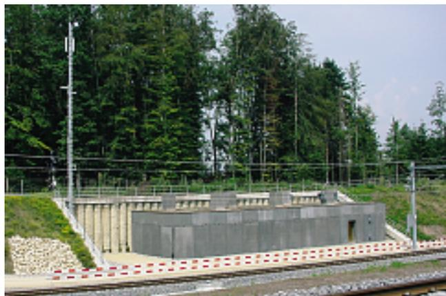
**Bild 10:** Relaisgebäude Wanzwil mit elektronischem Stellwerk (ESTW), SBB-Normgebäude mit umweltfreundlicher Steuerung des Wärmehaushalts und Antennenmast für GSM-R und GSM-P.
