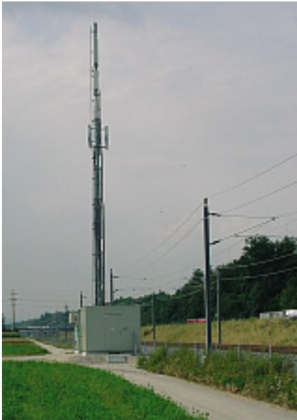
**Bild 11:** Freistehende GSM-R-Kabine und Antennenmast bei Koppigen.
