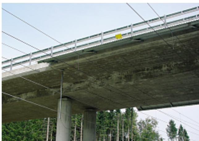
**Bild 18:** Überführung mit Schutzmaßnahmen: Schutzdach nach [13] von Bauwerk isoliert montiert, direkt an den Erdseilen der beiden Gleise geerdet.
