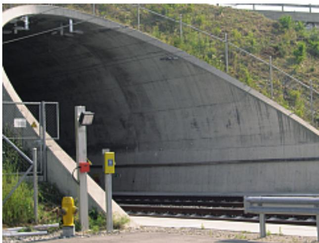
**Bild 16:** Tunnelportal mit Telefon, Fluchtwegbeleuchtung und Hydrant.
